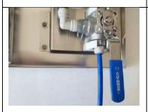
Blauer Hebel schaut nach unten. Nehmen sie einen Eimer zur Hand und halten sie den Spülschlauch hinein. Öffnen Sie langsam den Wasserzulauf am Eckventil. Die Filterkartusche füllt sich und aus dem Spülschlauch kommt Wasser. Die neue Filterkartusche muss ca. 5 Minuten gespült werden, damit Luft und überschüssige, lose Kohlepartikel ausgespült werden.
