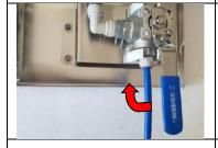
Hebel am Dreiwegehahn langsam in die waagrechte Position drehen.
