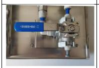
Spülschlauch entfernen und Blindstopfen einsetzen. System auf Dichtheit prüfen. Bei der Entnahmestelle solange Stillwasser zapfen, bis die Luft aus dem System entwichen ist und das Wasser klar ist. Sensorische und optische Prüfung machen.
